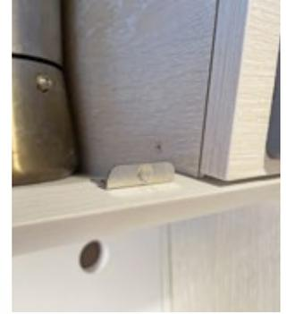
Tourne steckt viel Aufwand in eine umfassende Isolierung und in den „letzten Schliff“. Details wie selbstklebende Elastikpuffer an den Gegenhaltern überlassen andere Hersteller dem Kunden.
