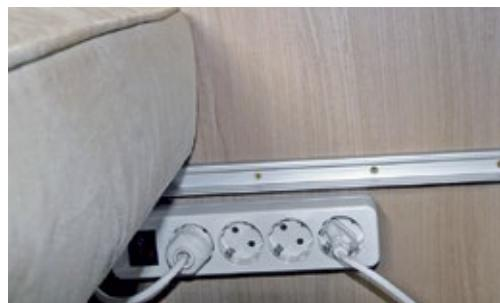
**Zusätzliche Zapfstellen: unsachgemäß angebrachte Steckerleiste.**
