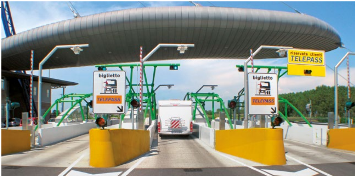
Die Durchfahrspuren – hier ganz rechts mit Telepass – erfordern die elektronische On-Board-Unit im Fahrzeug.
