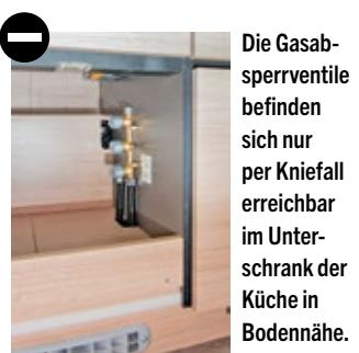
Die Gasabsperrventile befinden sich nur per Kniefall erreichbar im Unterschrank der Küche in Bodennähe.
