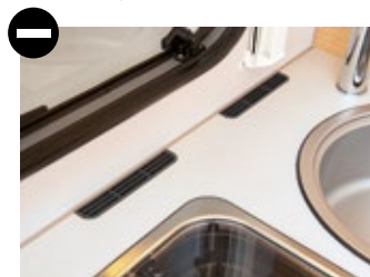
Gehören nicht in die Nähe der Spüle: Lüftungsgitter in der Arbeitsplatte.
