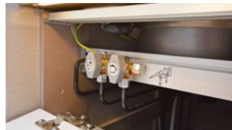
Gut platziert: Die Gasabsperrhähne sind hinter einer Blende an der Küchenfront leicht erreichbar.
